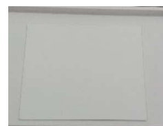
上からかぶせ開口 を塞ぎ裏から金具止め
