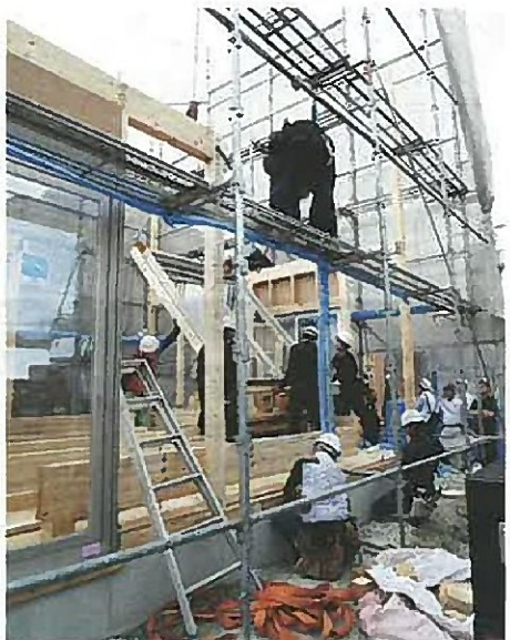
パネル工法の施工現場
