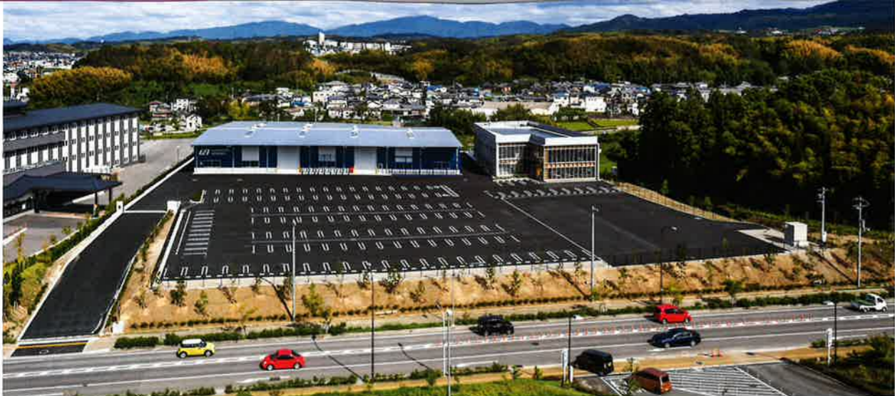
物流倉庫を併設した新社屋。会長の強い意志で、木造で建てているが、近代的なオフィスに仕上げた。その後ろには豊かな緑地が広がる*
