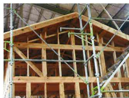
工場内で実際に軸組みによる建て方を実習
