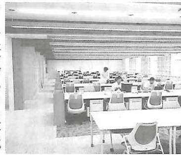
1階事務所は10.5mの大スパン
