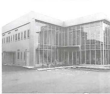
木造新事務所の外観
