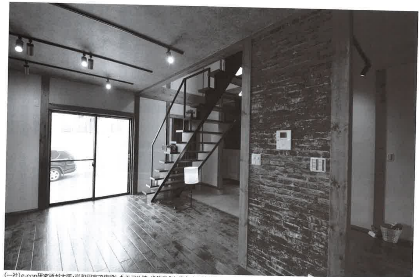
(一社)e-con研究所が大阪・岸和田市で建設したモデル棟。省施工化に寄与する様々な工法などを採用し、検証を行っているが、ここでは改めて真壁構造に注目。現在主流の大壁構造に比べて、断熱材や内装材のサイズの標準化を図りやすいという
