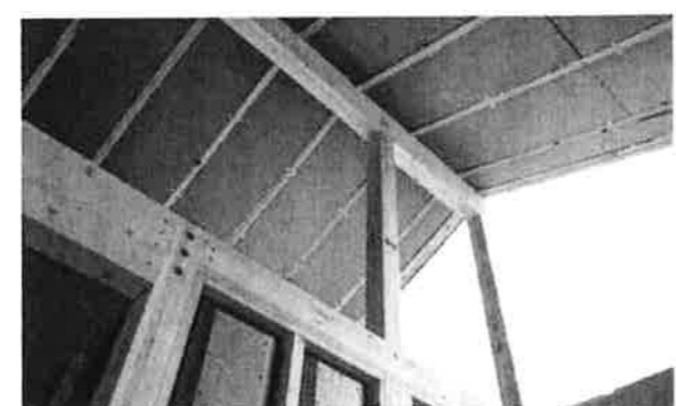
ソルツでは、EPS断熱材の表面に突起状部を設けた独自の屋根断熱材を採用。垂木間にはめ込むだけで通気層を確保できる
