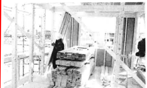
在来工法のフレーミング工事が約1週間かかるのに対して、物材が展開するソルツでは最短1日、長くても2日で終了する
